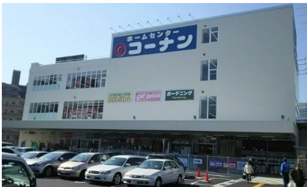
2017年10月にオープンした、広島県広島市の「ホームセンターコーナン広島皆実町店」
