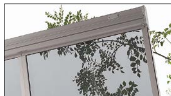
ポリカーボネート (クリアブルー(透明)) 全光線透過率:31%
