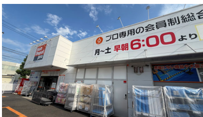
【建デポ川崎南加瀬店 外観】
