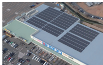
大東新田店(大阪府大東市)の自家消費型太陽光発電設備
